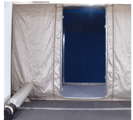
正面扉 取外し時
