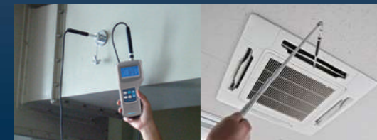
空調機器の能力試験・保守点検
