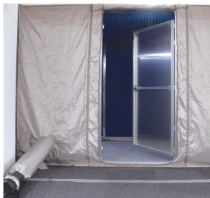
正面扉 取付時
