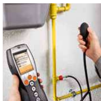
ガスパイプ圧テストセットを接続し、リーク率テスト、メインテスト、プレテスト、リーク検出の試験を実行
