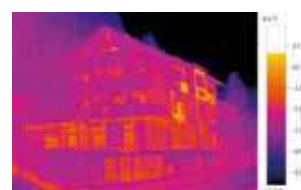
スケールアシストありの画像 ※断熱不良箇所が明確に解ります。
